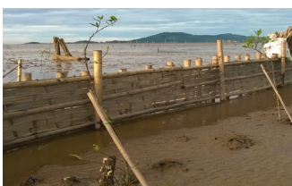
Hình 2: kết cấu tường mềm đơn Hình 3: kết cấu tường mềm kép
