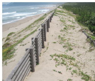
Hình 6: tường mềm bằng gỗ tạo cơ trồng cây trên cồn cát
