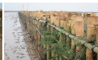
Hình 2: kết cấu tường mềm đơn Hình 3: kết cấu tường mềm kép
